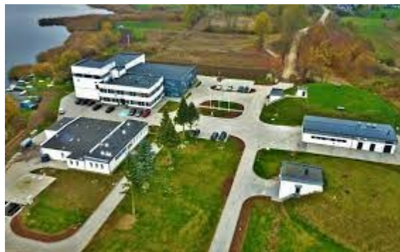
Stacja uzdatniania wody w Żąbrowie
