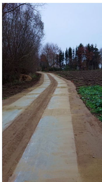
PRZEBUDOWA DROGI W MIEJSCOWOŚCI ŁASZKA
