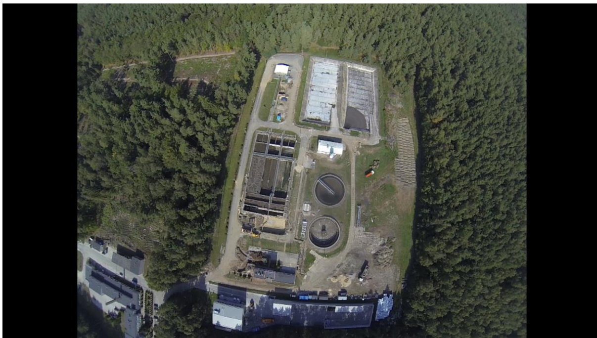
Oczyszczalnia ścieków Stegna
