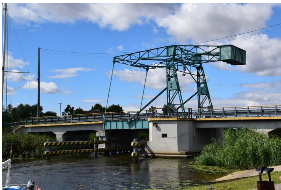
Most drogowy zwodzony na rz. Wiśle Królewieckiej w ciągu drogi nr 09171 Sztutowo ul. Gdańska
