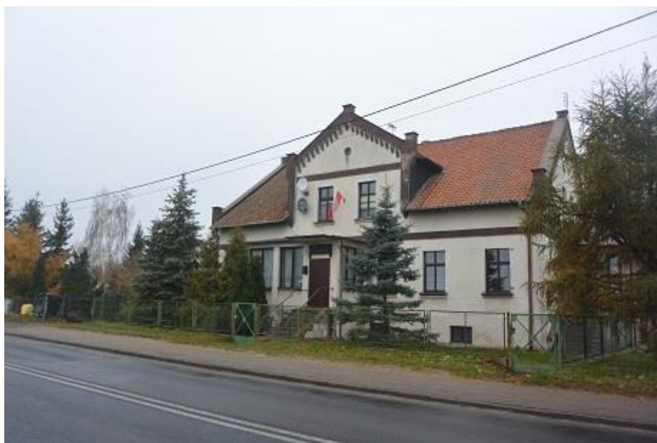
Dom z budynkiem gospodarczym Sztutowo ul. Gdańska 31
