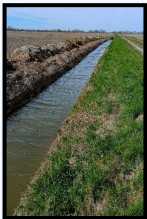
Fot. 3. Rów melioracyjny odmulony do poziomu projektowanych rzędnych dna, autor: W. Warowna
