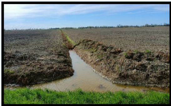
Fot. 5. Ujście częściowo utrzymanego rowu odwadniającego do rowu zbiorczego, autor: W. Warowna
