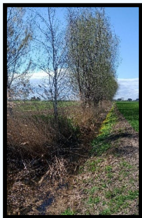
Fot. 4. Zamulony i zarośnięty rów melioracyjny o małej przepustowości, autor: W. Warowna
